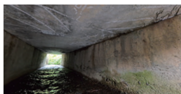
防水ジンバルカメラで撮影した溝橋内の映像
