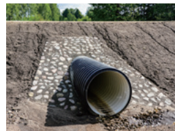
▲小口径で通水のない管路
