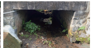
▲狭隘で水深の浅い溝橋
